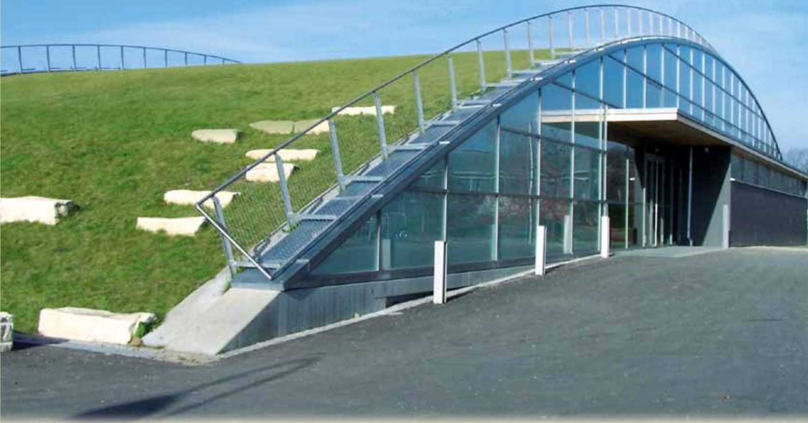
La superficie total de la cubierta del gimnasio del Colegio Clara Grunewald en Friburgo (Barrio de Rieselfeld) mide aprox. 1000 m 2
